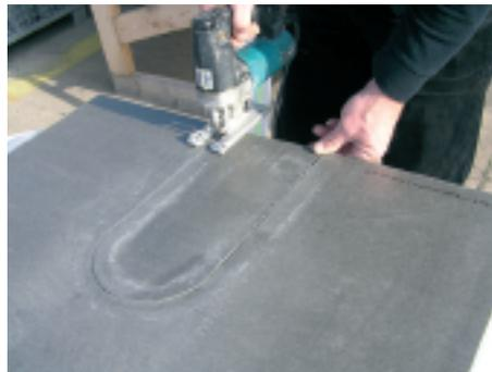
Mit der Stichsäge anschließend den Ausschnitt in der Fassadentafel vornehmen.
