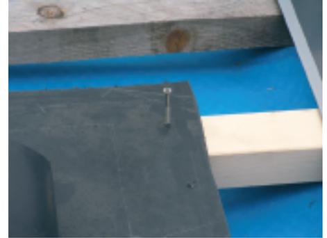
Befestigung der Grundplatte mit 2 Senkkopfschrauben.
