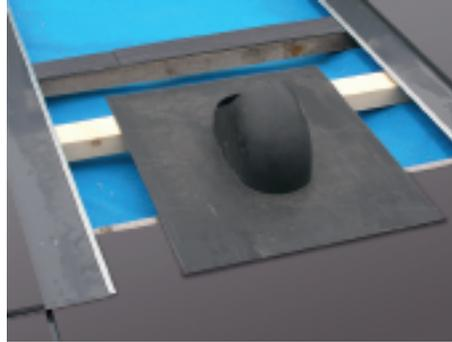
Grundplatte des Dachdurchgangs auf die Zusatzlatte aufsetzen. Auf eine ausreichende Überdeckung der Grundplatte auf die Fassadentafel ist zu achten.
