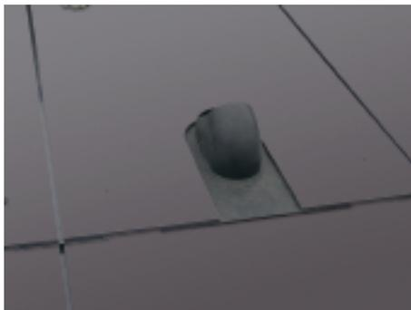
Die ausgeschnittene Fassadentafel so auflegen, dass der Dachdurchgang mittig im Ausschnitt liegt.
