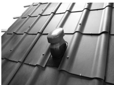
Eingebauter Universal Dachdurchgang mit Entlüfterstutzen flach DN 100
