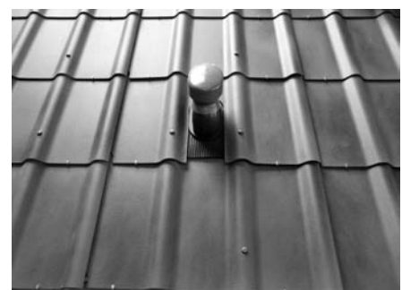
Eingebauter Universal Dachdurchgang mit Entlüfterstutzen flach DN 100
