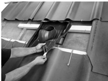
3. Verklebung des Universal Dachdurchganges
