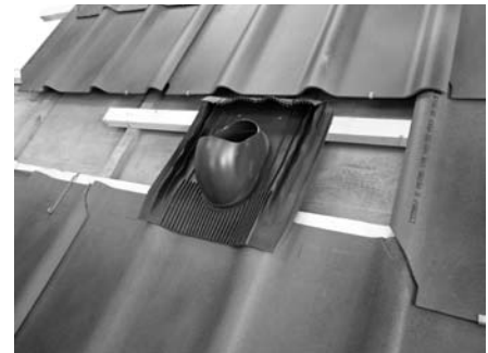
2. Einbau des Universal Dachdurchganges
