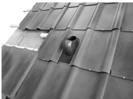
5. Eingebauter Universal Dachdurchgang
