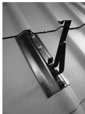
Stütze für Schneefanggitter
