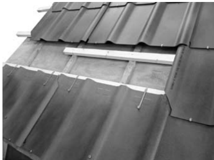
1. Einbau einer Zusatzlatte 40 x 60 mm
