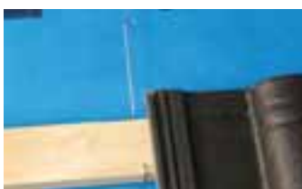
Die Sturmklammer links neben dem verlegten Dachstein auf die Traglattung aufstecken
