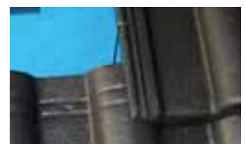
Den Haken der Eternit Sturmklammer zum Einhängen über den Seitenfalz des Dachsteins hängen
