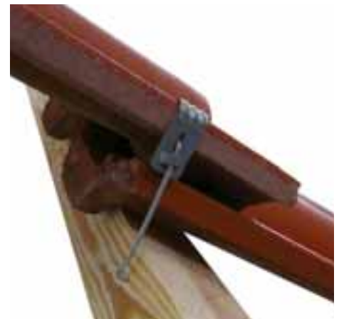
Eingebaute Eternit Sturmklammer zum Einschlagen
