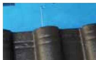
Den nächsten linken Dachstein verlegen und auch die nächsten Sturmklammern vormontieren
